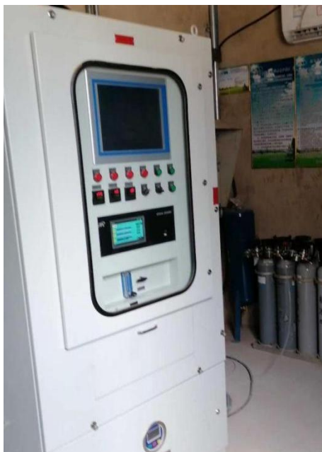
油浆萃取装置导热油炉废气在线监测设施
