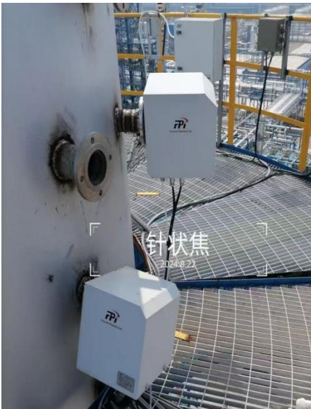
针状焦装置干燥器加热炉、焦化塔加热炉燃烧废气在线监测设施
