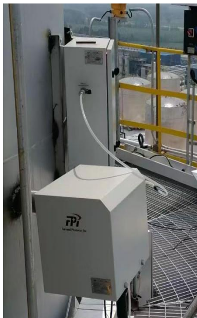
油浆萃取装置导热油炉废气在线监测设施
