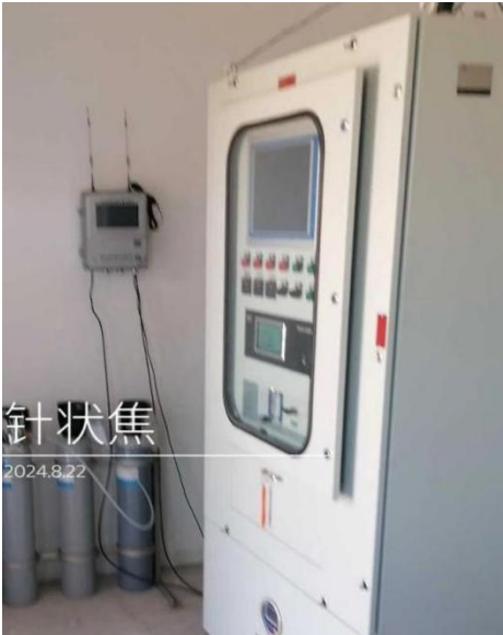
针状焦装置干燥器加热炉、焦化塔加热炉燃烧废气在线监测设施
