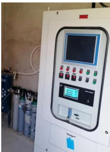
天然气制氢装置转化炉废气在线监测设施
