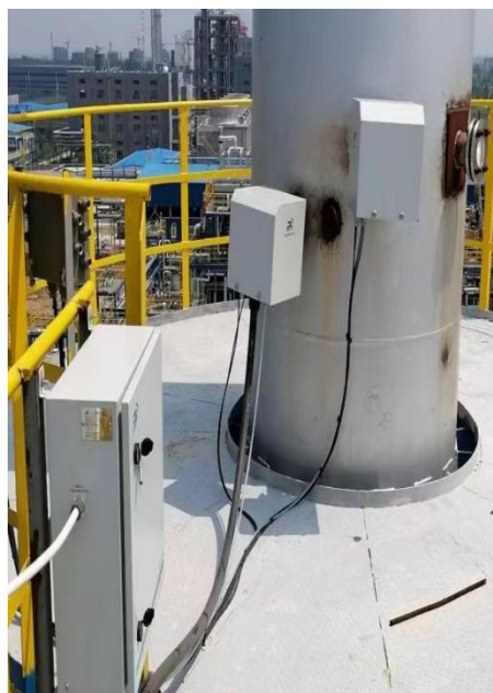
天然气制氢装置转化炉废气在线监测设施
